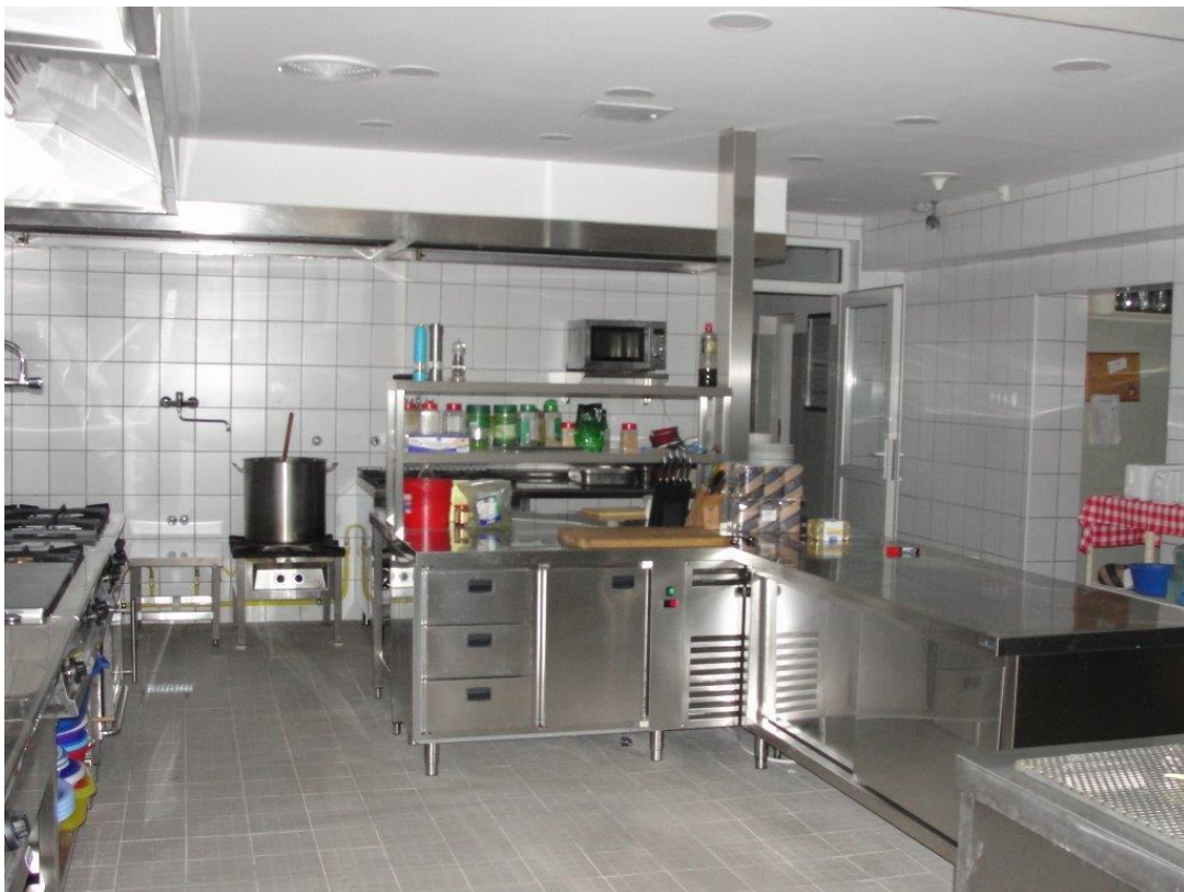
Új konyhatechnológia beépítése
