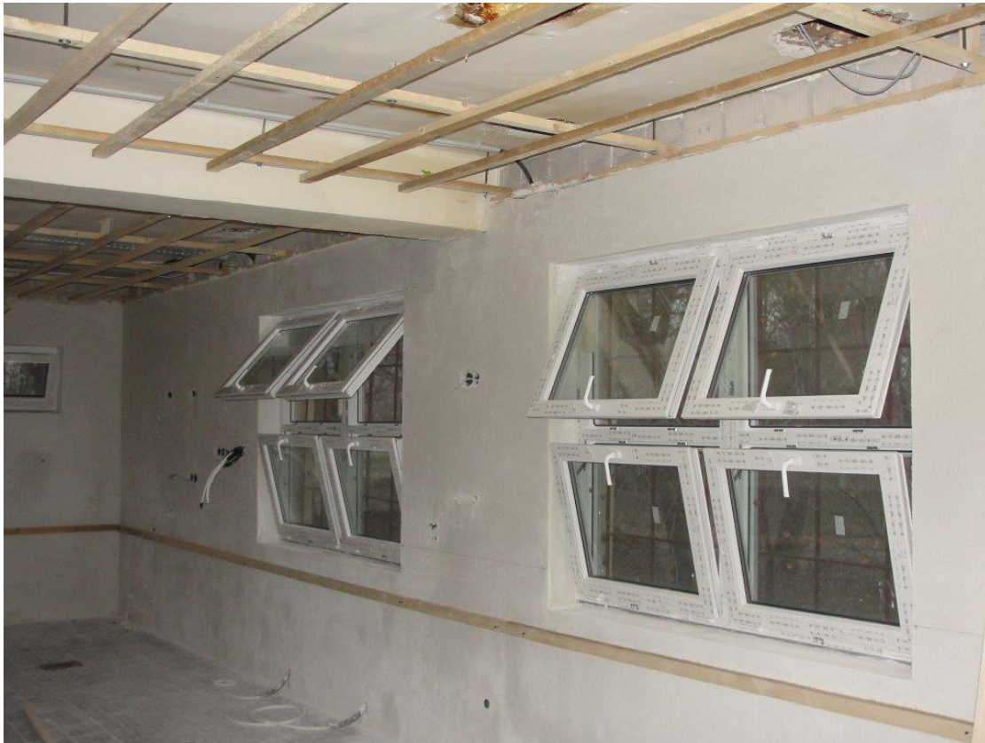
Új nyílászárók beépítése
