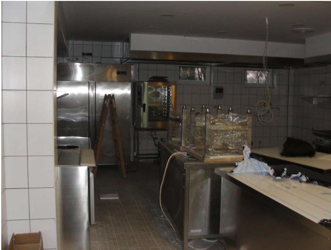
Új konyhatechnológia beépítése
