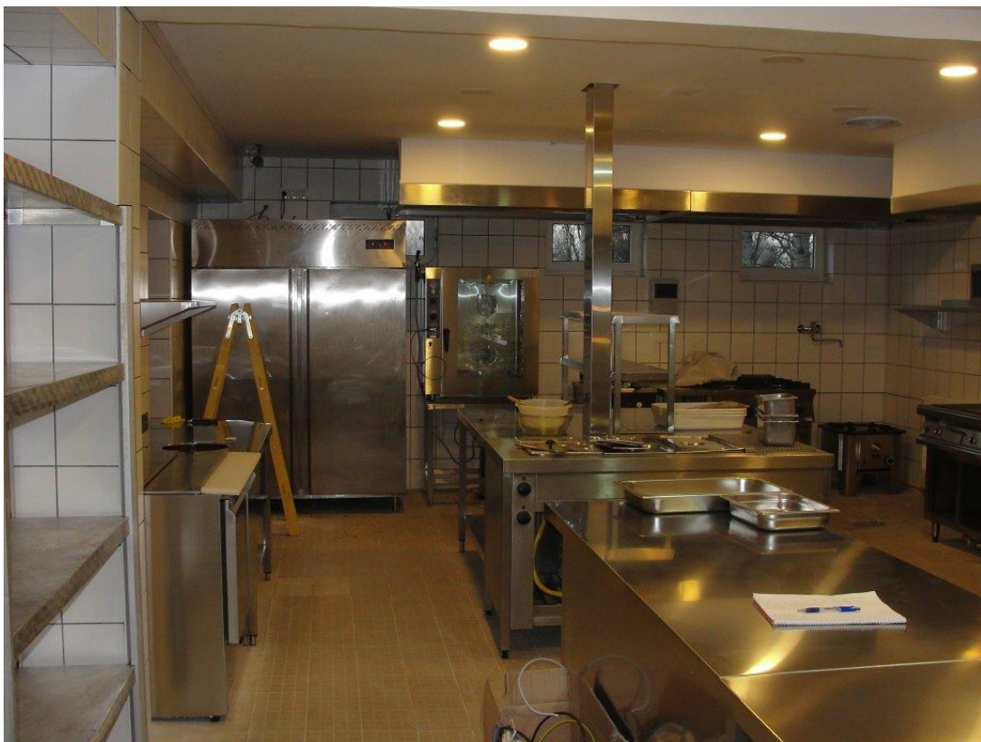
Új konyhatechnológia beépítése
