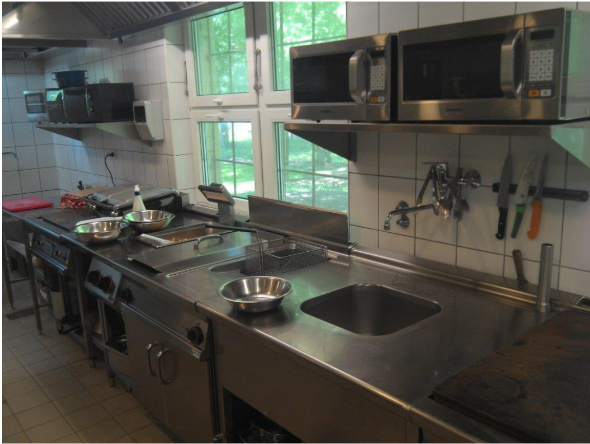
Új konyhatechnológia beépítése
