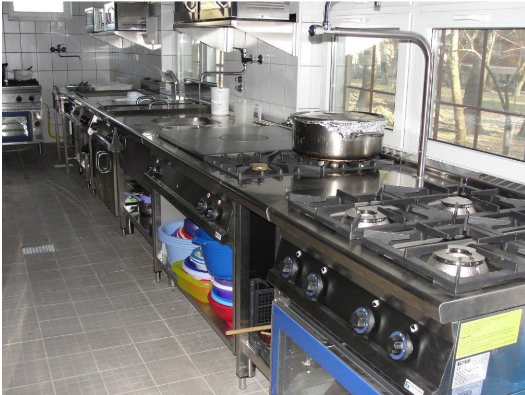
Új konyhatechnológia beépítése
