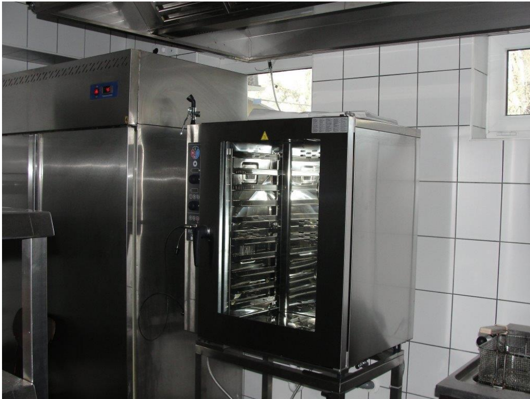
Új konyhatechnológia beépítése
